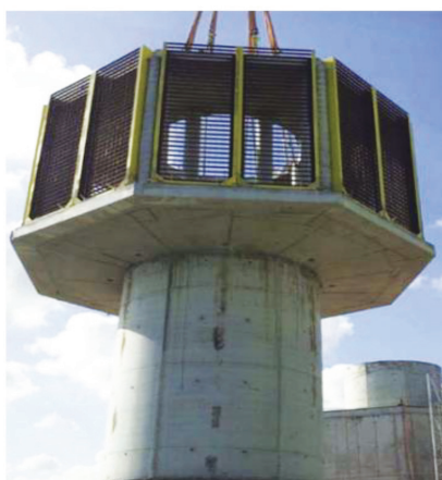
شکل ۱: برج ورودی عمودی با آشغالگیر درشت
